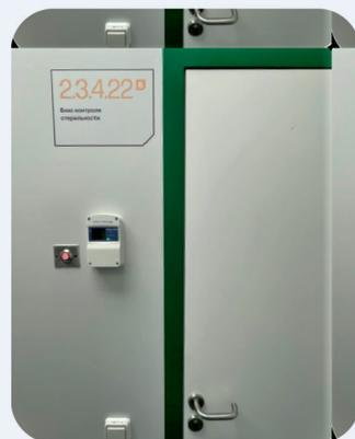
Пример установки узла ПИРС-CAN в чистые помещения со скрытым монтажом
