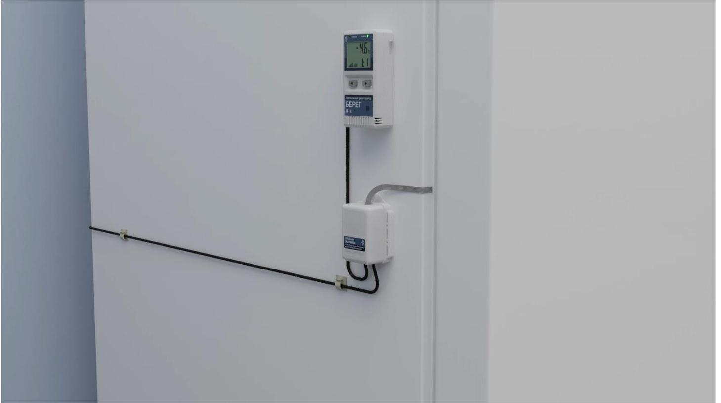
Рис. 7 Применение Берег-РП в аптечном складе. Размещение прибора с тройником (на магнитах)
